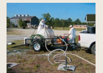
その後、HRCアドバンストのマイクロ乳濁液が処理エリアに大量に注入されます。
